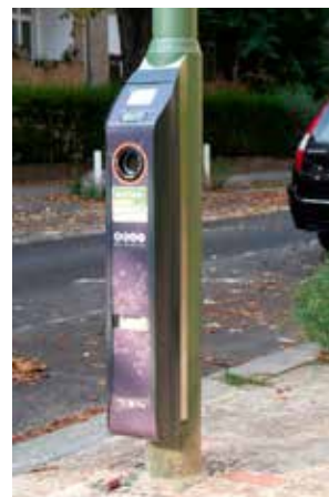
Straßenleuchte mit Ladestation (EBEE) für Elektrofahrzeuge in Berlin-Friedenau
